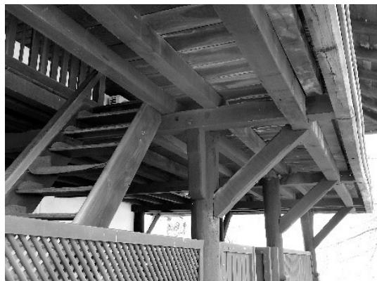
Slika 6: Drvena konstrukcija isturene galerije iznad trijema u Džindjiskoj džamiji (2019) (foto: autor)
