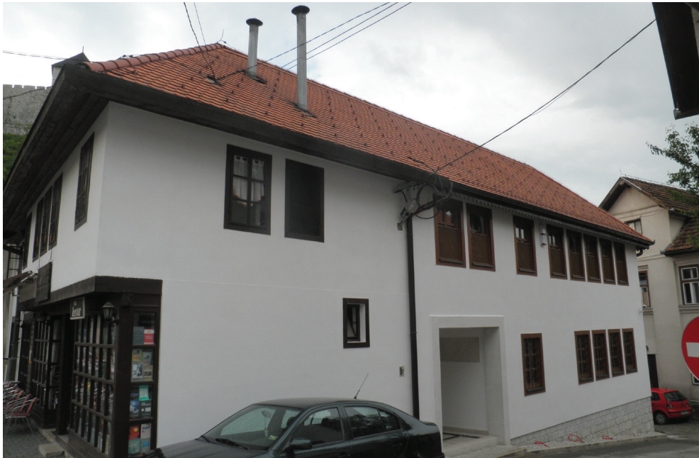
Eksterijer - izgled objekta nakon intervencije
