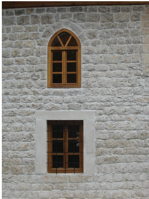
Doprozornici i fasadni zidovi nakon završenih radova
