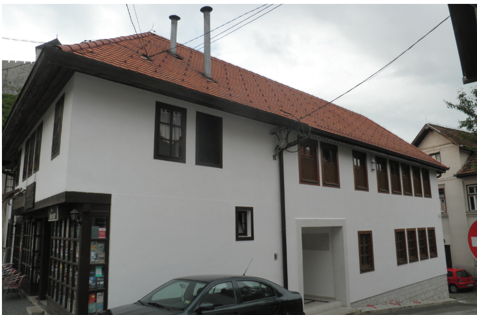
Eksterijer - izgled objekta nakon intervencije
