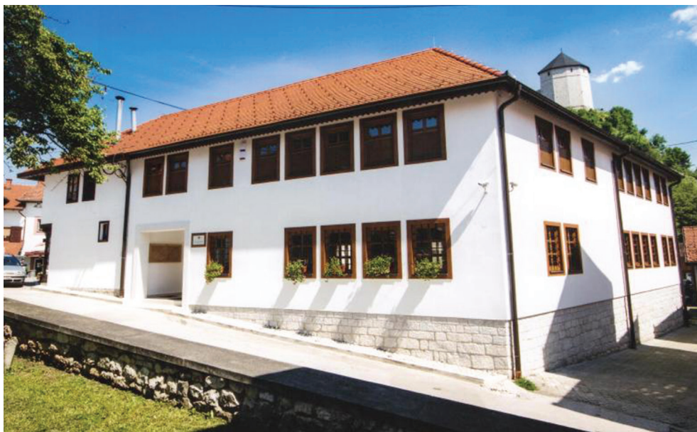
Eksterijer - izgled objekta nakon intervencije
