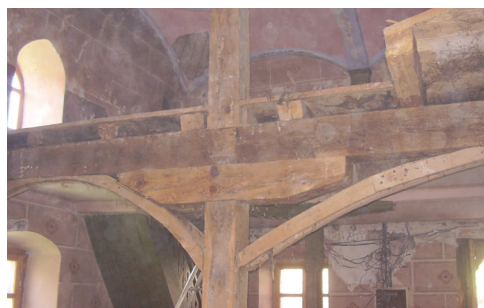
Ručna demontaža mahfila, 2008. god.
