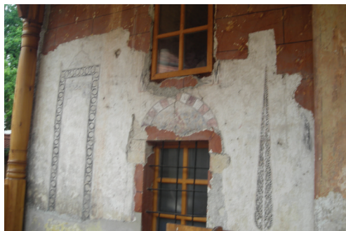
Sondiranje maltera na sofama iz 2001. god.
