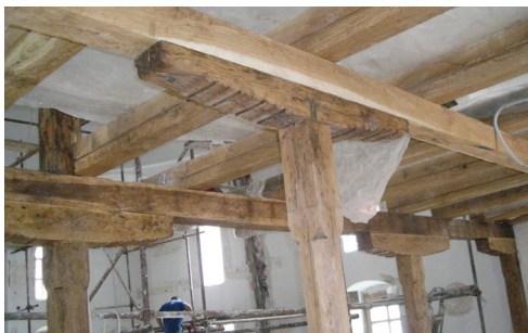
Konstruktivna sanacija mahfila
