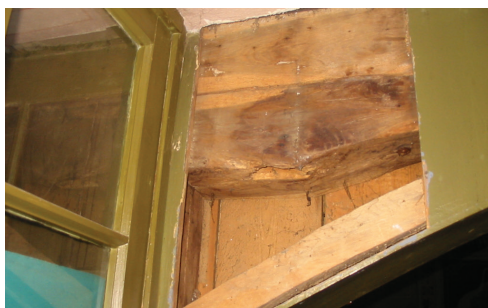
Skidanje daščane oplata sa mahfila
