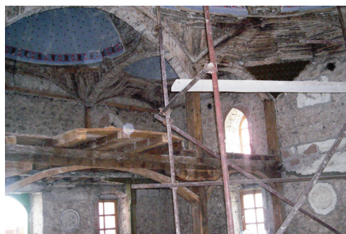
Obijen malter sa kupola otkriva da na mjestu mahfila nema čorstog kamenog zida
