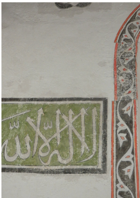
Originalni detalj ornamentike koji je poslužio da se restaurira cijela šara oko gornjih prozora
