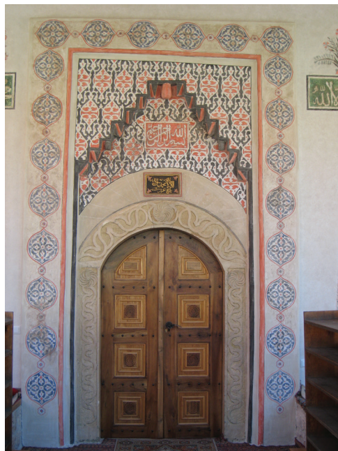
Ulazni portal sa vratima nakon završenih radova 2011. god.
