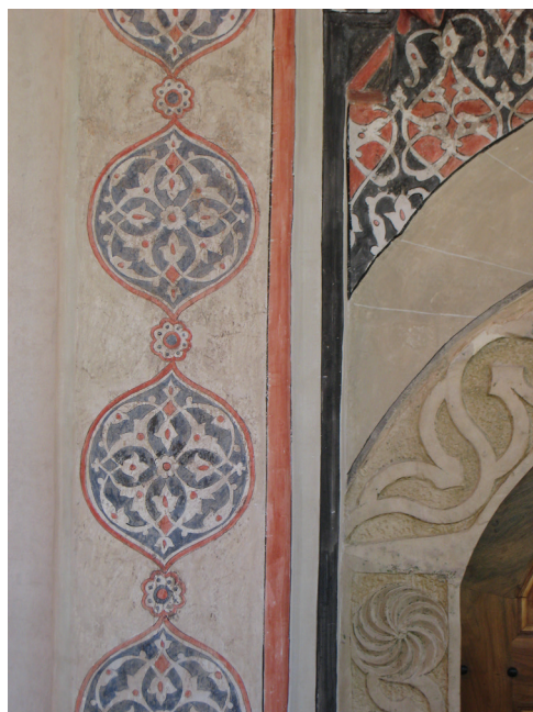
Izgled šare na portalu nakon restauracije
